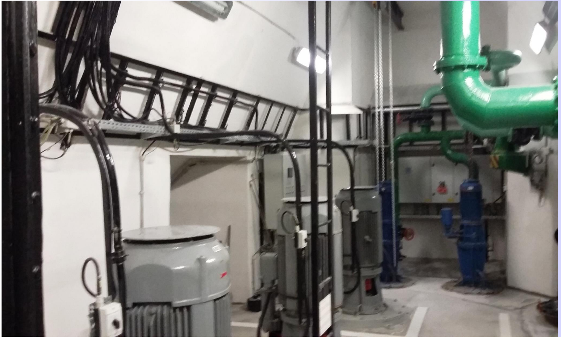
Kiskörei Vízerőmű víztelenítő gépház falfelület javítása.
