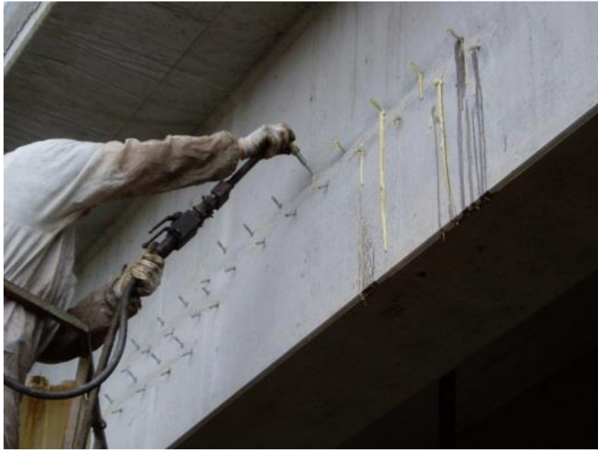
Hídgerenda repedésének javítása PU injektálással
