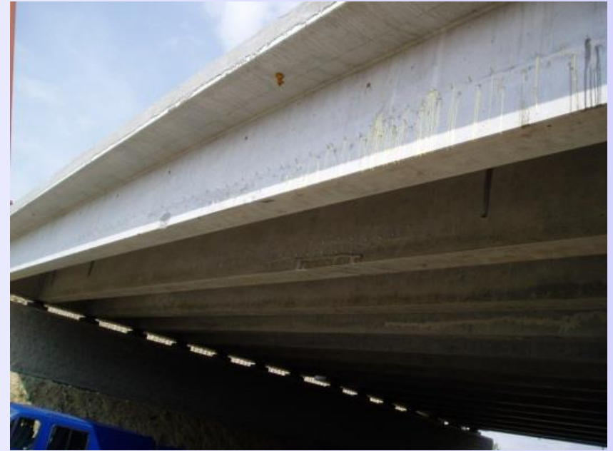
Hídgerenda repedésének javítása PU injektálással
