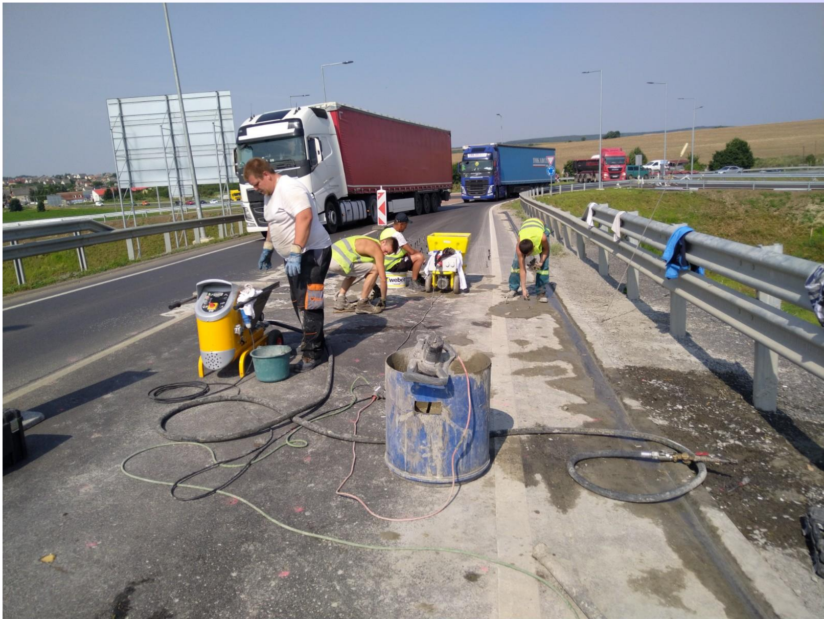
Útpálya erősítés habcementtel, félpályás lezárással
